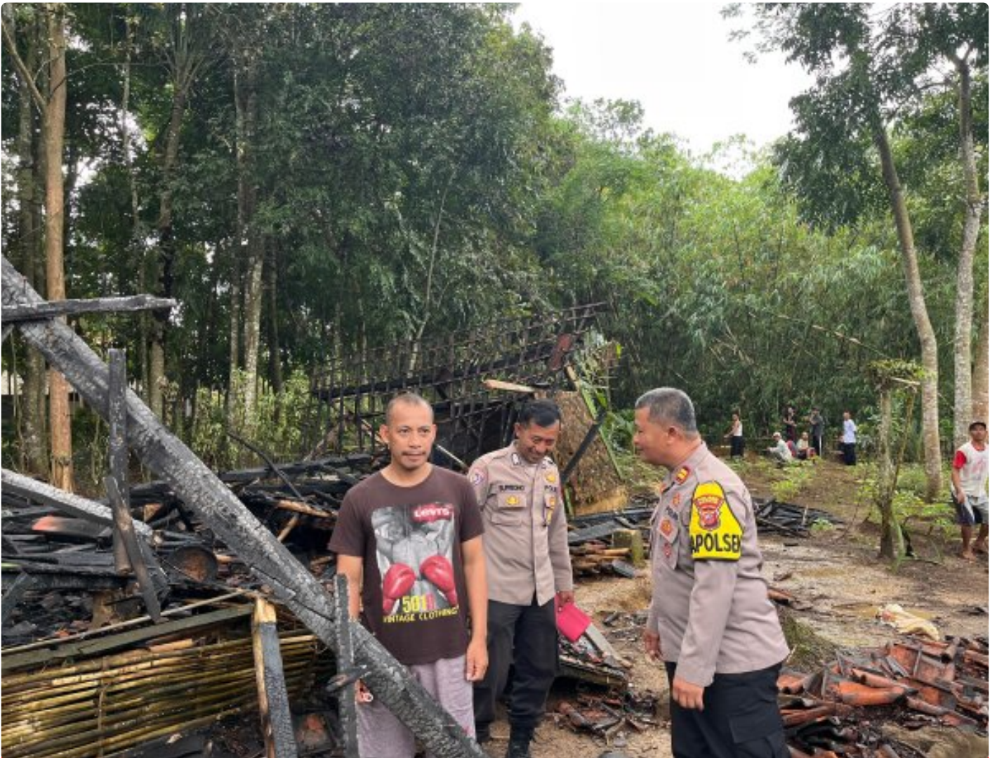
Kebakaran Rumah Panggung di Kp. Banjaran Desa Wanasari Kapolsek Surade Cek Lokasi Kebakaran
